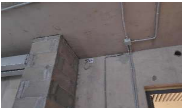
Фото 97. Квартира 173, кадастровый номер 78:07:0003189:680.
