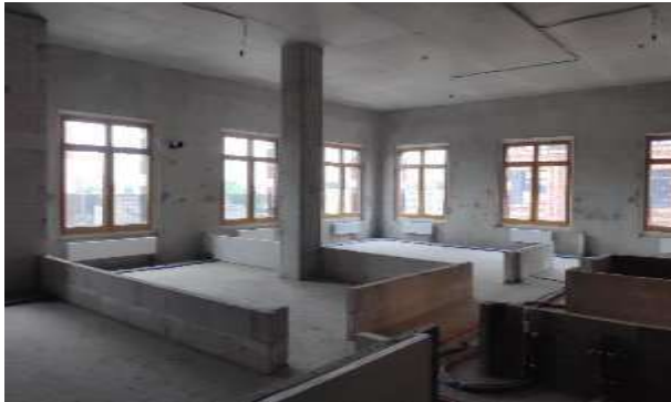
Фото 171. Квартира 209, кадастровый номер 78:07:0003189:721.
