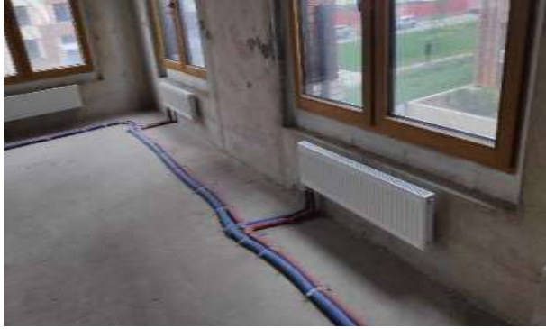
Фото 89. Квартира 173, кадастровый номер 78:07:0003189:680.
