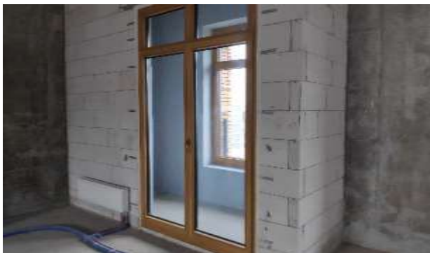
Фото 67. Квартира 130, кадастровый номер 78:07:0003189:633.
