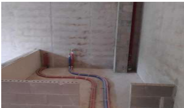
Фото 115. Квартира 175, кадастровый номер 78:07:0003189:682.
