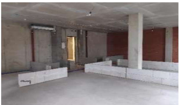
Фото 85. Квартира 173, кадастровый номер 78:07:0003189:680.
