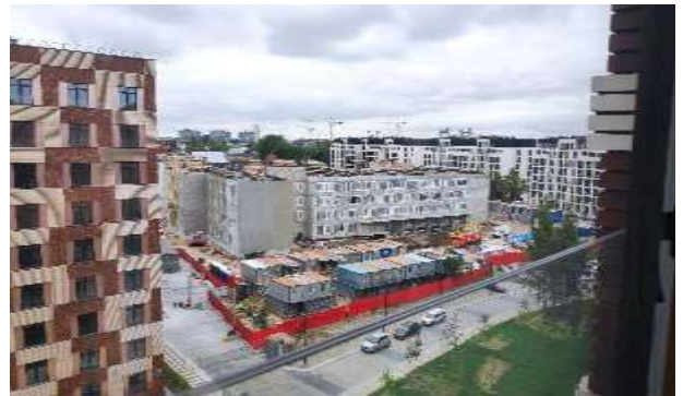
Фото 174. Квартира 209, кадастровый номер 78:07:0003189:721.
