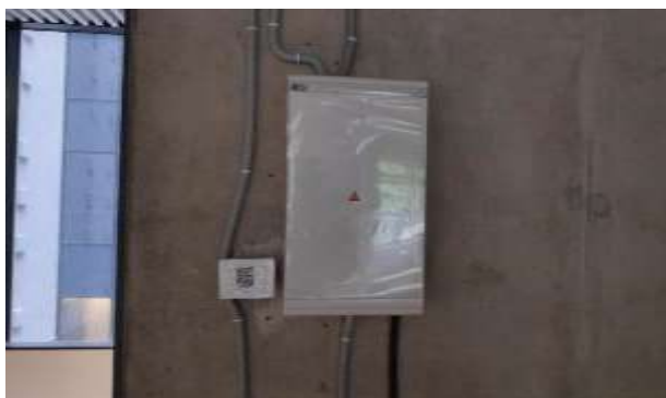
Фото 134. Квартира 175, кадастровый номер 78:07:0003189:682.
