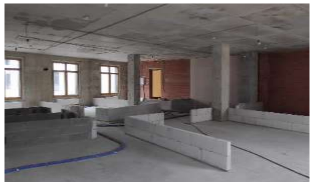
Фото 192. Квартира 70, кадастровый номер 78:07:0003189:819.
