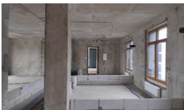
Фото 56. Квартира 129, кадастровый номер 78:07:0003189:632.
