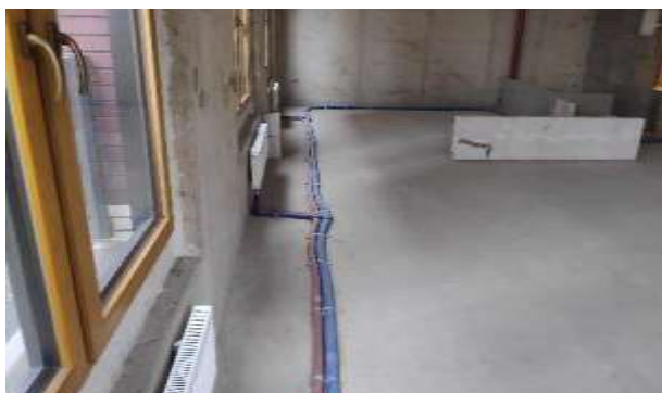
Фото 86. Квартира 173, кадастровый номер 78:07:0003189:680.
