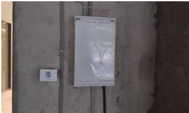
Фото 157. Квартира 180, кадастровый номер 78:07:0003189:688.
