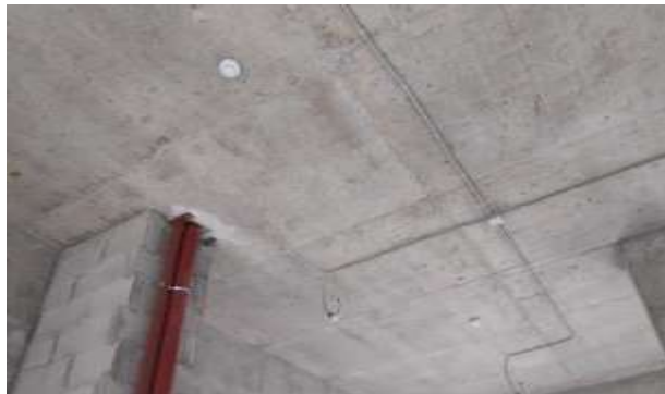
Фото 75. Квартира 130, кадастровый номер 78:07:0003189:633.
