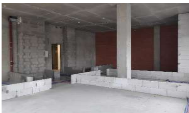
Фото 166. Квартира 209, кадастровый номер 78:07:0003189:721.
