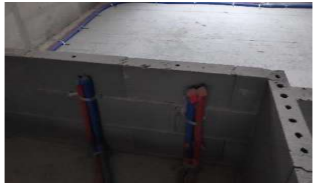
Фото 190. Квартира 70, кадастровый номер 78:07:0003189:819.
