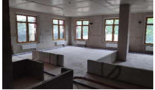
Фото 138. Квартира 180, кадастровый номер 78:07:0003189:688.
