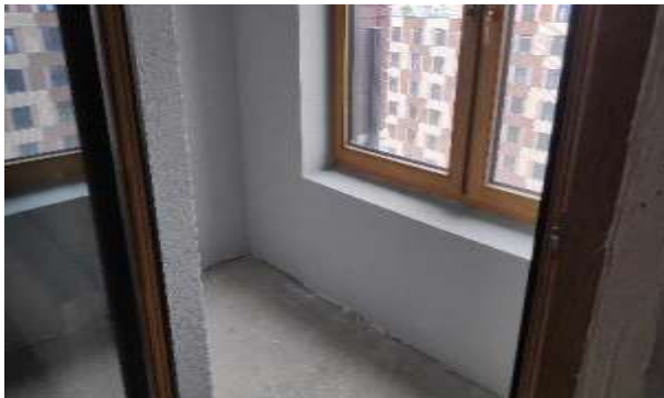
Фото 173. Квартира 209, кадастровый номер 78:07:0003189:721.
