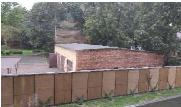
Фото 129. Квартира 175, кадастровый номер 78:07:0003189:682.
