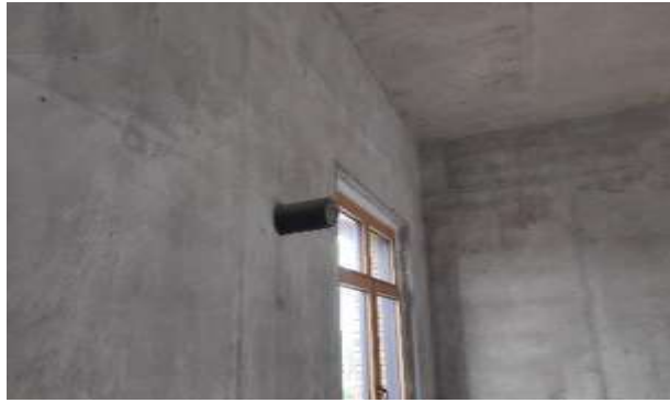
Фото 73. Квартира 130, кадастровый номер 78:07:0003189:633.
