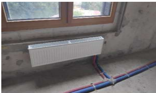
Фото 40. Квартира 129, кадастровый номер 78:07:0003189:632.
