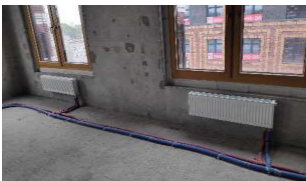
Фото 165. Квартира 209, кадастровый номер 78:07:0003189:721.
