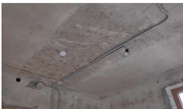
Фото 54. Квартира 129, кадастровый номер 78:07:0003189:632.
