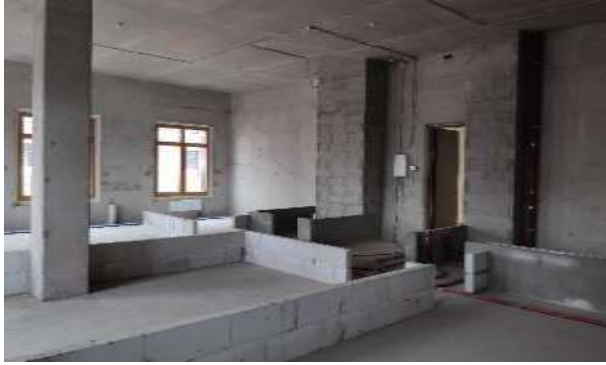
Фото 169. Квартира 209, кадастровый номер 78:07:0003189:721.
