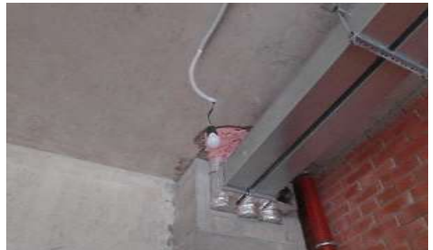
Фото 124. Квартира 175, кадастровый номер 78:07:0003189:682.
