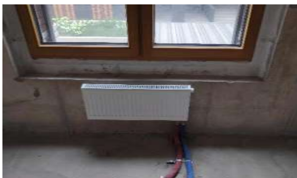
Фото 88. Квартира 173, кадастровый номер 78:07:0003189:680.
