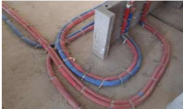
Фото 107. Квартира 173, кадастровый номер 78:07:0003189:680.
