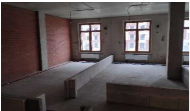
Фото 83. Квартира 173, кадастровый номер 78:07:0003189:680.
