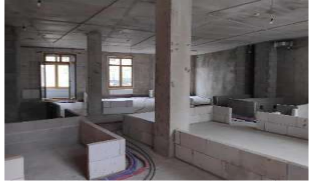
Фото 186. Квартира 70, кадастровый номер 78:07:0003189:819.
