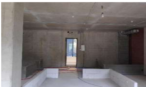
Фото 132. Квартира 175, кадастровый номер 78:07:0003189:682.
