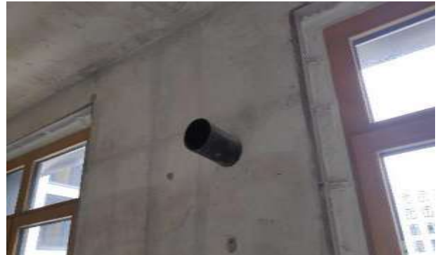
Фото 188. Квартира 70, кадастровый номер 78:07:0003189:819.
