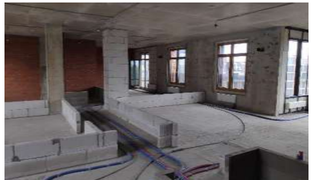
Фото 32. Квартира 129, кадастровый номер 78:07:0003189:632.
