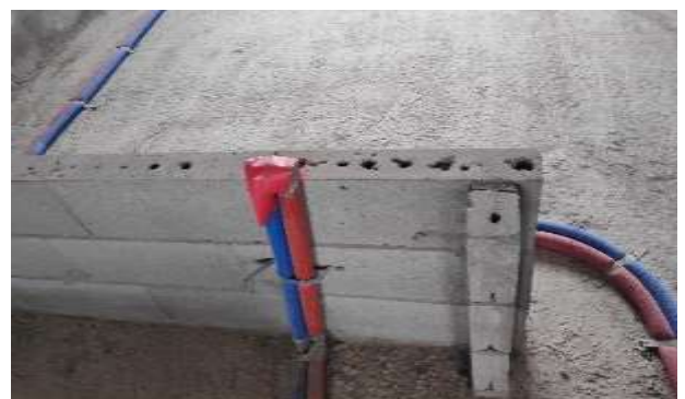
Фото 64. Квартира 130, кадастровый номер 78:07:0003189:633.
