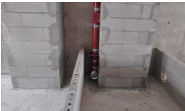
Фото 191. Квартира 70, кадастровый номер 78:07:0003189:819.
