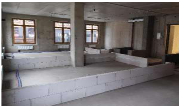
Фото 84. Квартира 173, кадастровый номер 78:07:0003189:680.
