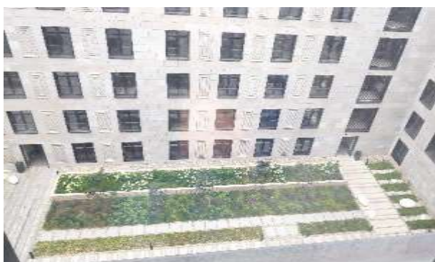
Фото 24. Квартира 106, кадастровый номер 78:07:0003189:606.
