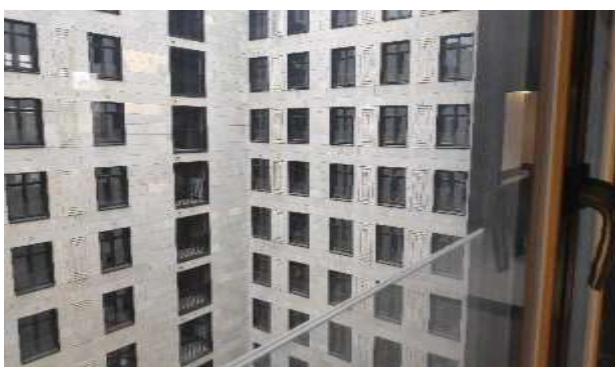
Фото 23. Квартира 106, кадастровый номер 78:07:0003189:606.
