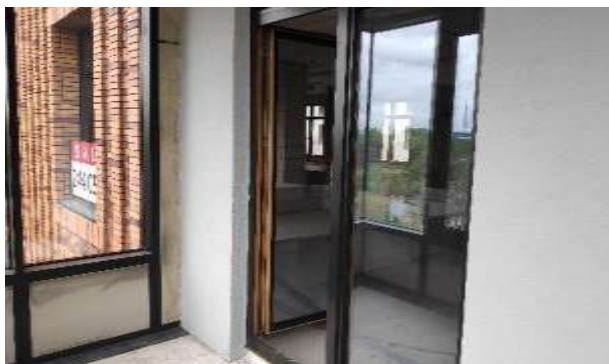
Фото 20. Квартира 106, кадастровый номер 78:07:0003189:606.
