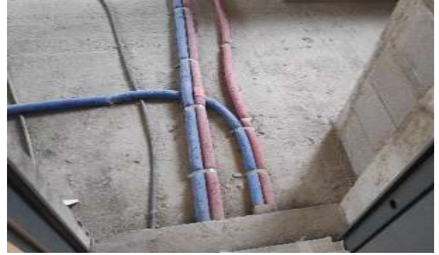
Фото 58. Квартира 130, кадастровый номер 78:07:0003189:633.
