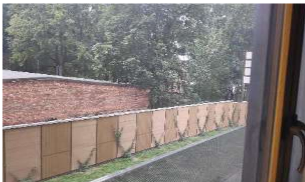
Фото 130. Квартира 175, кадастровый номер 78:07:0003189:682.
