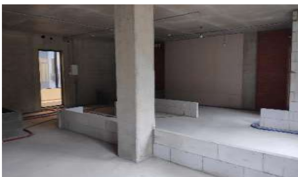
Фото 119. Квартира 175, кадастровый номер 78:07:0003189:682.
