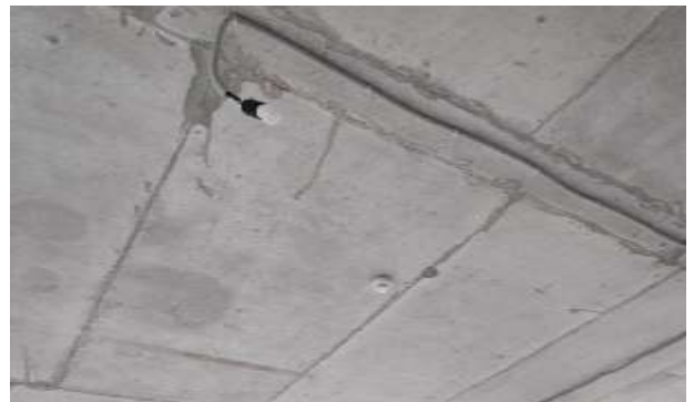
Фото 14. Квартира 106, кадастровый номер 78:07:0003189:606.
