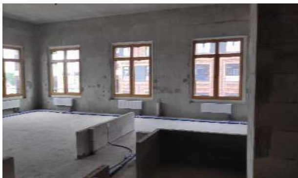
Фото 162. Квартира 209, кадастровый номер 78:07:0003189:721.
