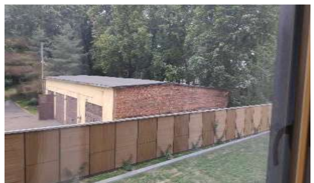
Фото 128. Квартира 175, кадастровый номер 78:07:0003189:682.
