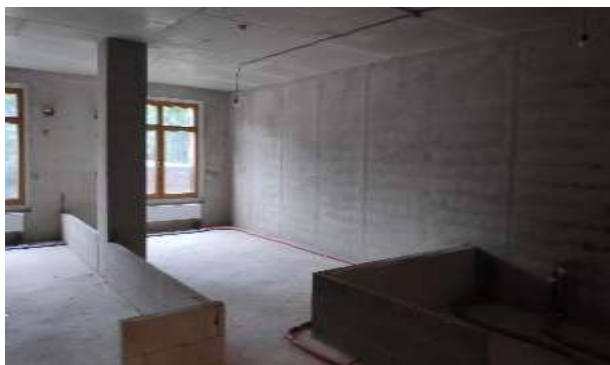
Фото 114. Квартира 175, кадастровый номер 78:07:0003189:682.
