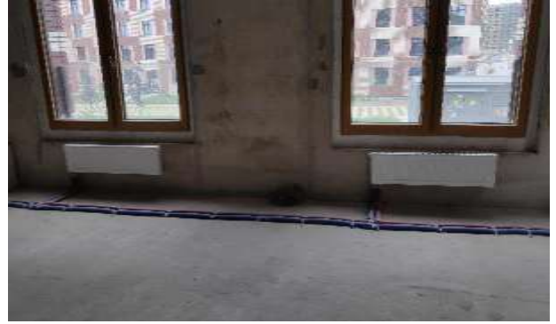
Фото 90. Квартира 173, кадастровый номер 78:07:0003189:680.
