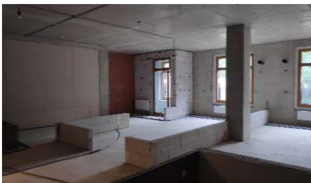
Фото 117. Квартира 175, кадастровый номер 78:07:0003189:682.
