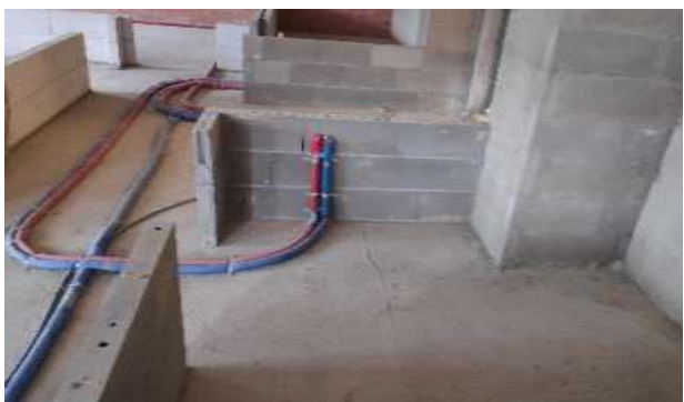
Фото 149. Квартира 180, кадастровый номер 78:07:0003189:688.
