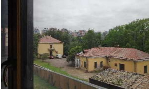
Фото 153. Квартира 180, кадастровый номер 78:07:0003189:688.
