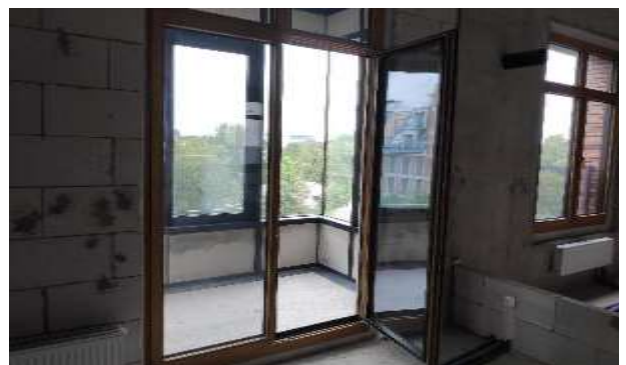
Фото 16. Квартира 106, кадастровый номер 78:07:0003189:606.
