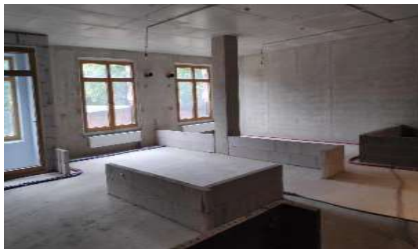
Фото 125. Квартира 175, кадастровый номер 78:07:0003189:682.
