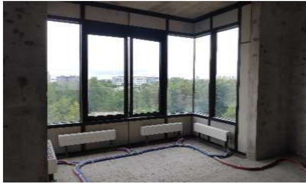
Фото 41. Квартира 129, кадастровый номер 78:07:0003189:632.
