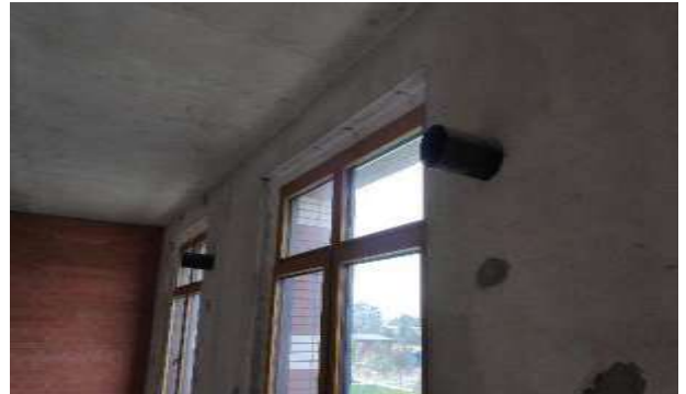
Фото 92. Квартира 173, кадастровый номер 78:07:0003189:680.
